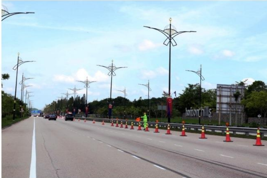
当局在施工路段放置了明显的安全防护栏及标牌，提醒公众在经过路段时放慢车速。
