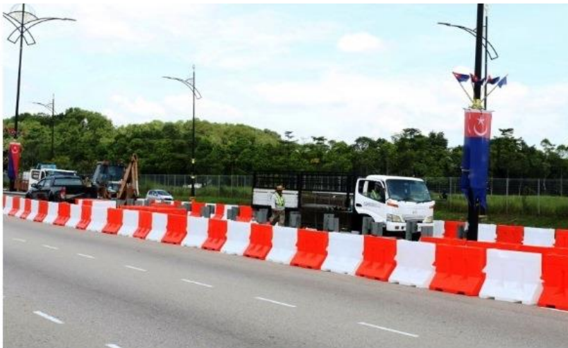
工作人员在苏丹依斯干达大道4.4公里处的双向快速车道（fast lane）进行施工工程，方便参与测试的巴士顺利通行。
