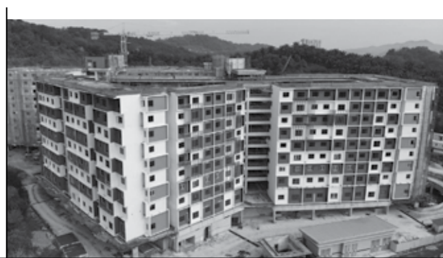
DWI@Rimbun Kasia - Actual site progress photo (October 2024)
